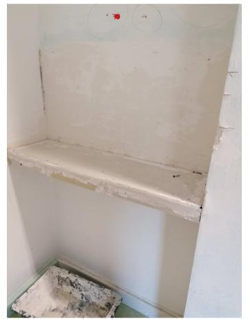
Etape 2 : on a mit les plaques de plâtres sur les railles et les montants
