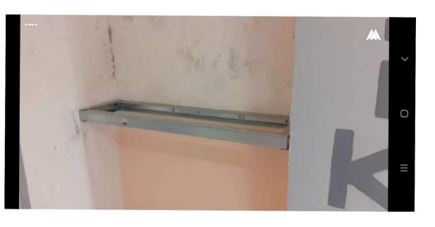
• Étape 1 : on a visé des railles et des montants
